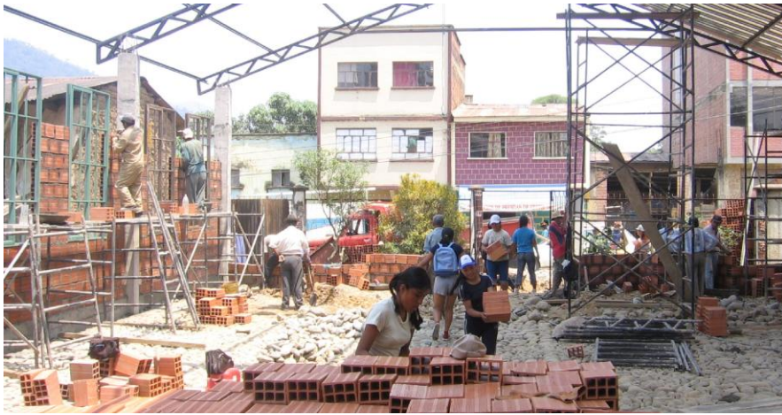
Bau eines neuen Gemeindehauses in Yapacani. Dieter Sarfert (S-140) aus Schneeberg übernahm die Maurer- und Elektroinstallationsarbeiten.
